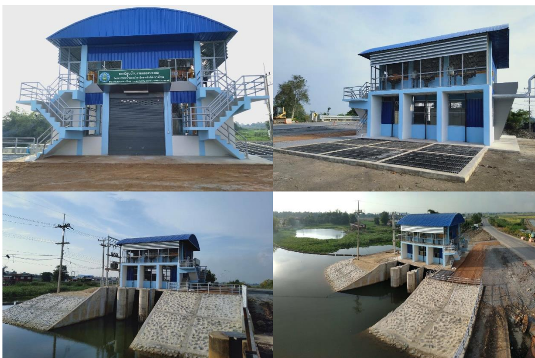
ภาพที่ 1.1 สถานีสูบน้ำปลายคลองบางซอ
